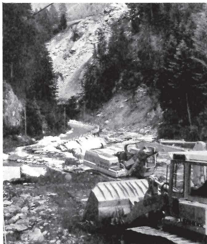
Der Hang zwischen St. Peter und Prettau droht noch immer abzurutschen. Weitere 50.000 bis 60.000 Kubikmeter Erde könnten ins Tal stürzen. Am heutigen Montag werden die Sicherungsarbeiten beginnen. Aufnahme: „D“/G. Mayr
