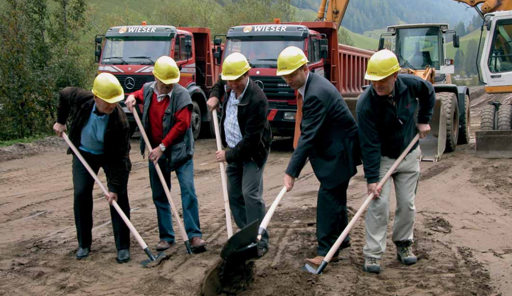
2006: Sternstunde für den Bürgermeister Alois Brugger (rechts) im 16. Amtsjahr – Spatenstich zum Elektro-Kraftwerk „Ahrstufe 1“
