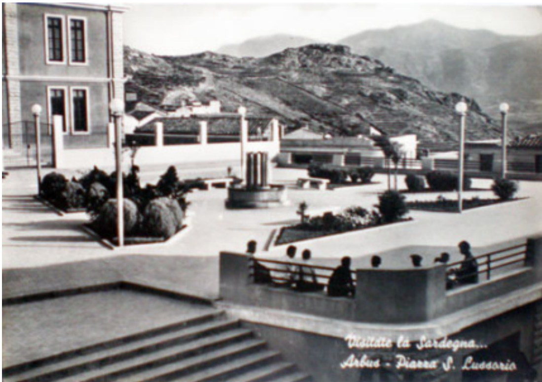
ARBUS – San Lussorio . La nuova piazza S. Lussorio negli anni '60: alle sue spalle le scuole elementari e sullo sfondo il massiccio del monte Linas.
