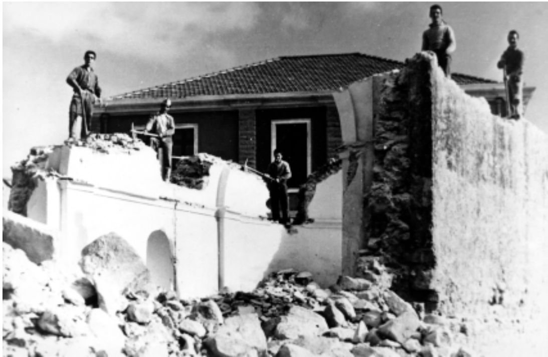
ARBUS – San Lussorio . Operai in posa, immortalati dal fotografo durante i lavori di demolizione della chiesa nel 1957
