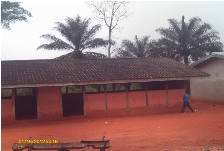
Photo 2: Salle de classe du CES inachevée.
