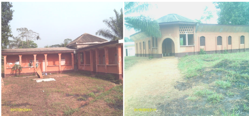
Photo 4 Bâtiments du Centre médical d'arrondissement.
