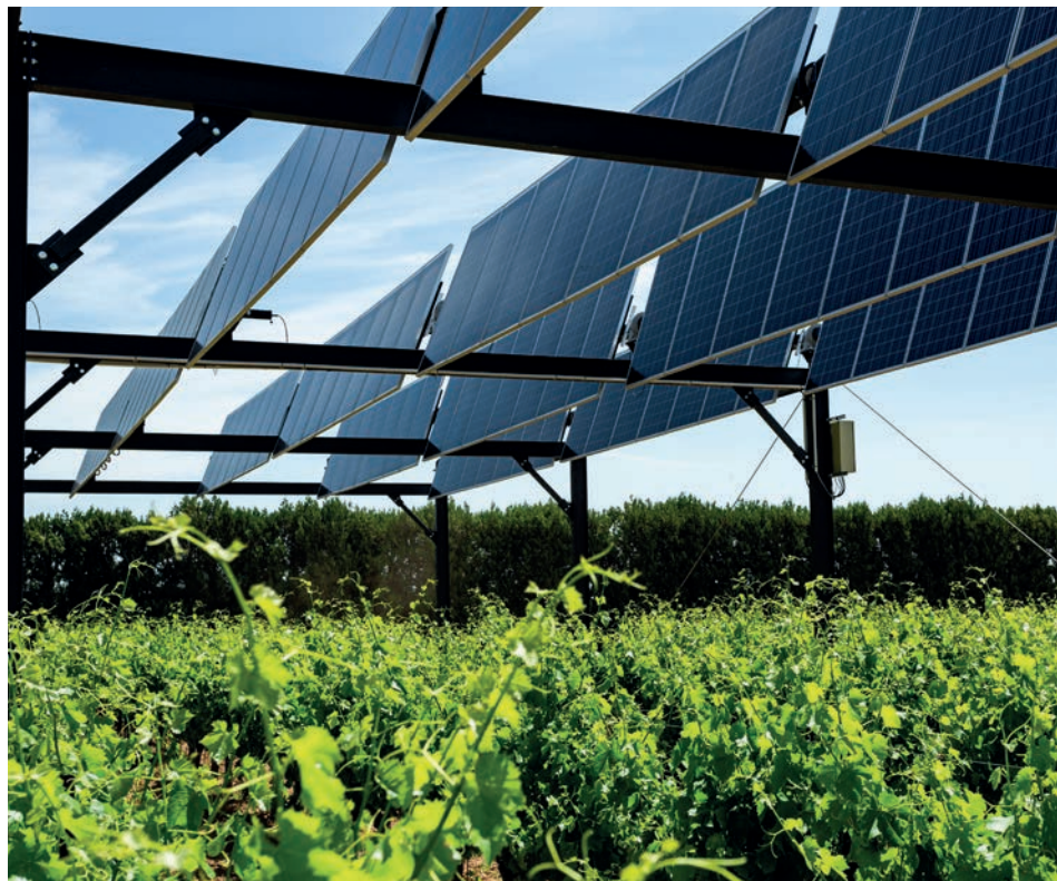
Abb. 45 Einachsiges Tracker-system einer Demonstrations-anlage in Frankreich. © Sun'Agri
