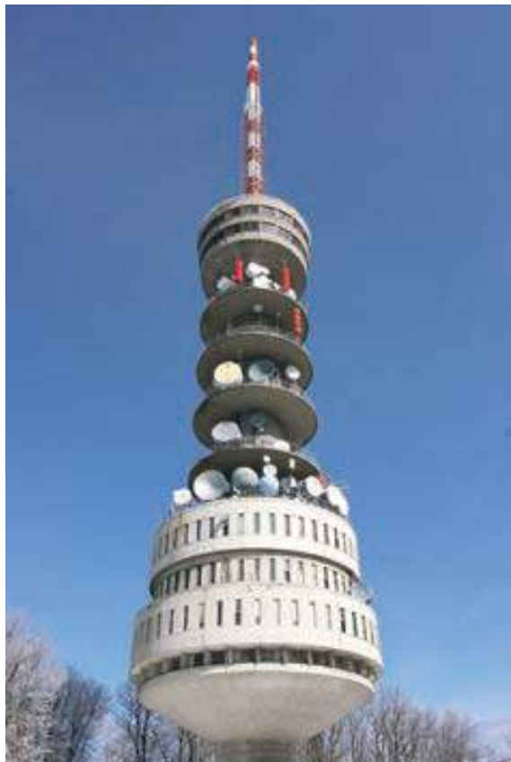
ODAŠILJAČ, toranj na Sljemenu s radijskim, televizijskim i drugim odašiljačima i antenama
