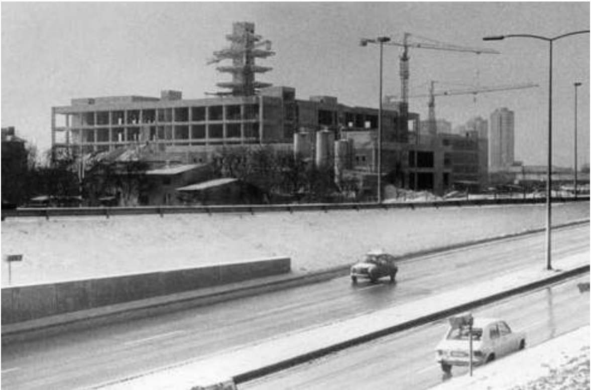
Dom RTZ-a u izgradnji
