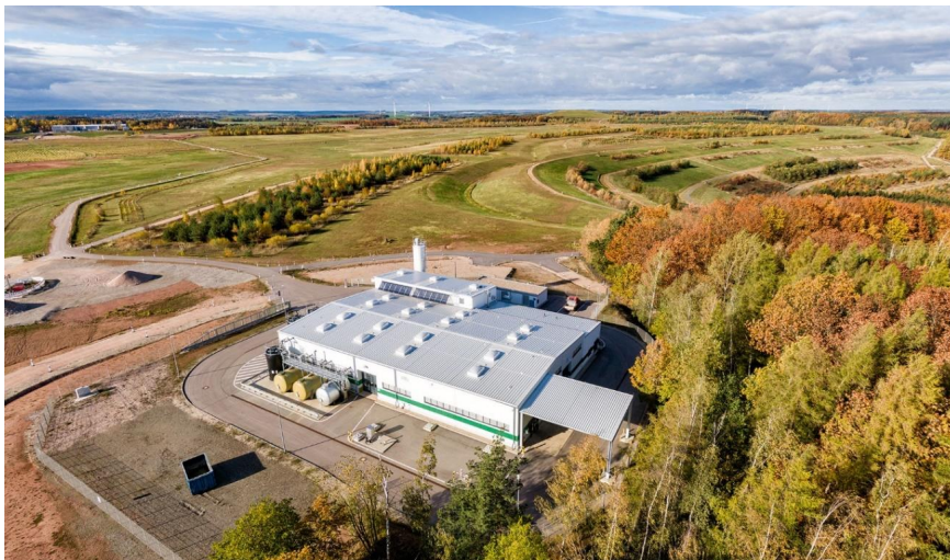
Abb. 3: Die neu errichtete Wasserbehandlungsanlage in Helmsdorf reinigt in Zukunft alle anfallenden kontaminierten Wässer der Absetzanlage (Bildrechte: Wismut GmbH)
