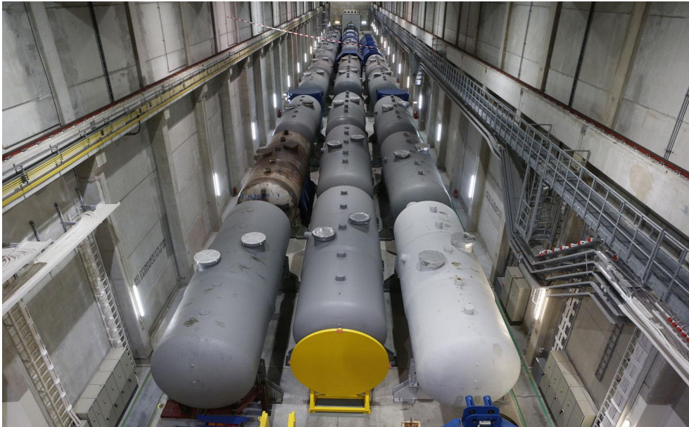
Abbildung D-7: Abklinglagerung von Großkomponenten (Dampferzeuger) im Zwischenlager Nord (Bildrechte: EWN)
