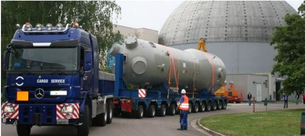
Abbildung D-20: Abtransport des Dampferzeugers aus dem Kernkraftwerk Obrigheim (Bildrechte: EnBW)
