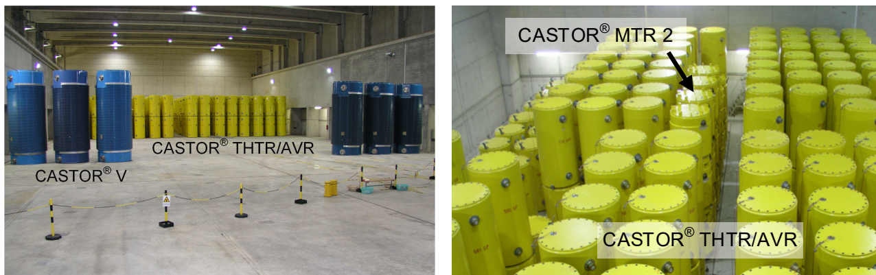
Abbildung D-5: Blick in das Brennelemente-Zwischenlager Ahaus (Bildrechte: BGZ)
