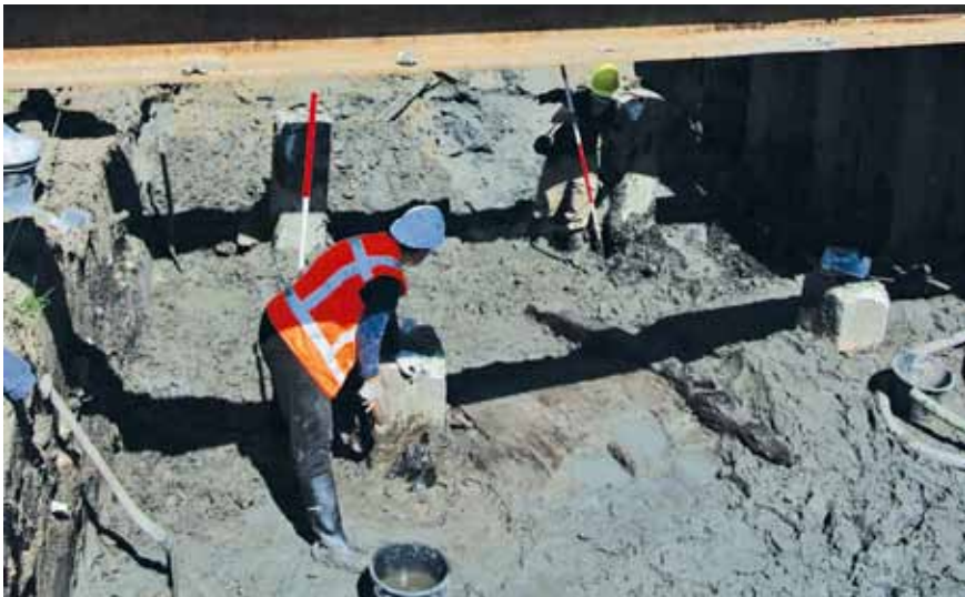
Hoekpolder-gemaal. In de bouwput zijn tussen de moderne betonnen heipalen de houten resten van de helling van het windas zichtbaar. Foto: Gemeente Rijswijk/SenS/REO/Archeologie.
