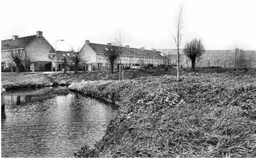
Aanleg van de Hoekpolder
