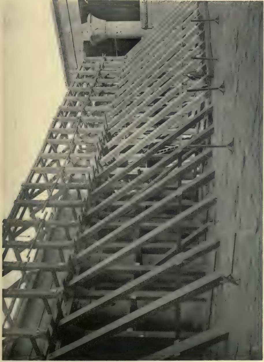
L'échafaudage achevé. — 30 janvier 1906.
