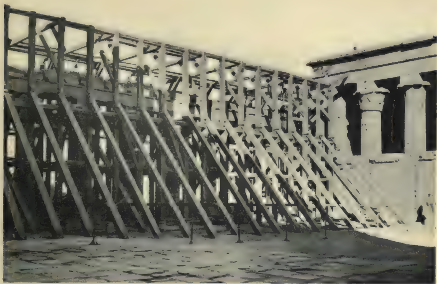
Charpente complète. — Façade intérieure.
