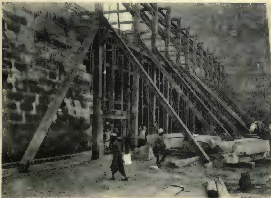
Charpente complète. — Façade extérieure.
