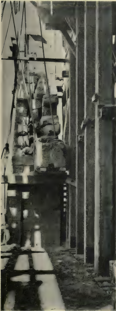
Démontage des blocs sur l'épaisseur du mur.
