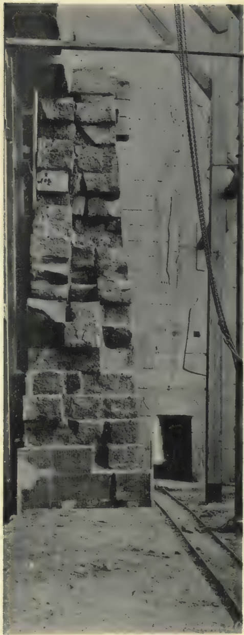
Le mur démoli, vu en épaisseur et nu.
