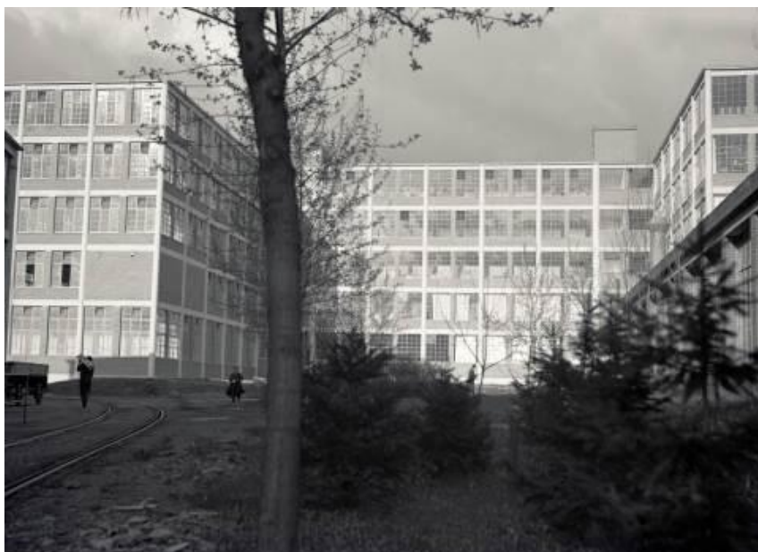
Obrázek č. 1: Mohutná budova Výzkumného ústavu v Bařových závodech, v jehož části jsou také konstrukční oddělení strojíren. Budova č. 64–65 má v půdorysu tvar písmene "H".
