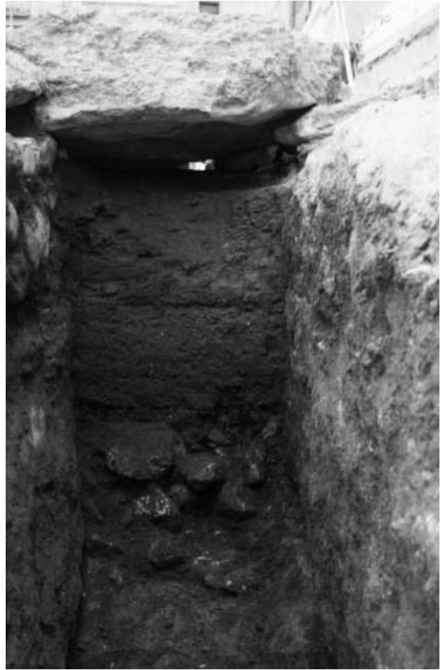
FIGURA II. Detalle de la cloaca situada en una plaza adyacente al foro de la colonia. Obsérvese un relleno inicial de piedras, supuestamente tras la desaparición de la cubierta, y la posterior sedimentación de capas limosas de presunto origen pluvia. Foto: Codex / J. M. Macias.
