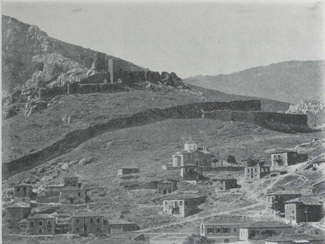
Fig. 10. — Vista exterior del castell de Livadia
