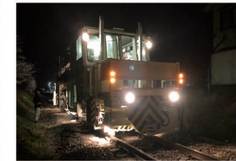
①マルチプルタイタンパーによる保線作業の様子
