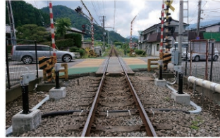
① 文科大学踏切 (障害物検知装置カラー舗装)
