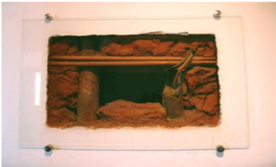
FIGURA 50 – No segundo pavimento do museu: janela que mostra a estrutura em pau-a-pique Fonte: Arquivo particular de Bruno Galery, 2008.
