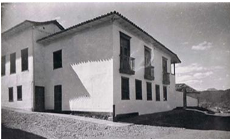
FIGURA 11 - Fachada do Museu do Ouro após restauração. Percebe-se o fechamento da varanda de quina que havia durante a obra Fonte: Documento cedido pelo Museu do Ouro, 1945.
