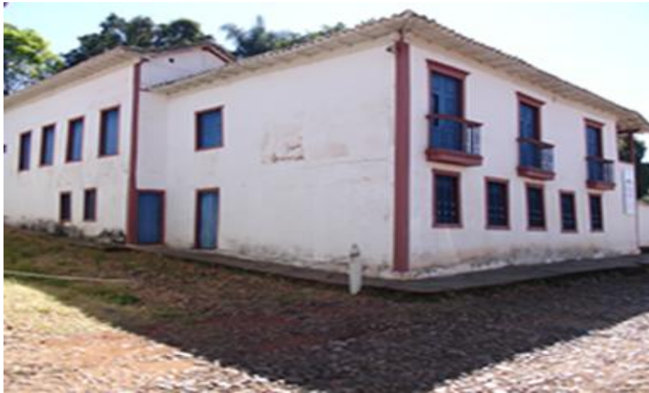
FIGURA 1 – Fachada lateral esquerda e frontal do Museu do Ouro Fonte: Arquivo pessoal da autora, 2008.
