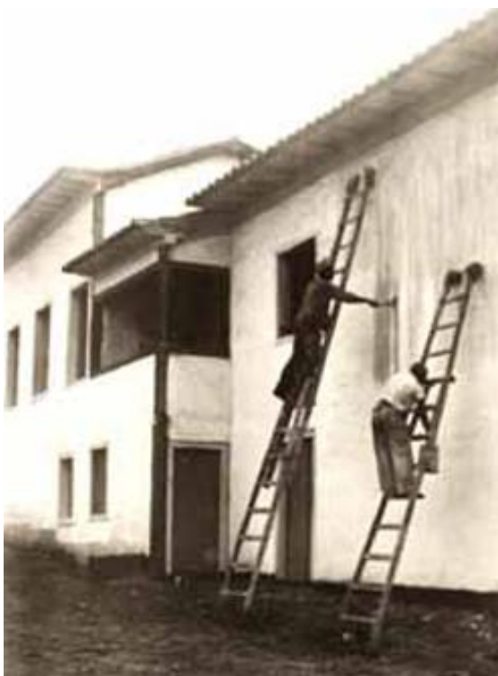
FIGURA 10 - Ciação feita durante a restauração do Museu do Ouro Fonte: Documento cedido pelo Museu do Ouro, 1945.
