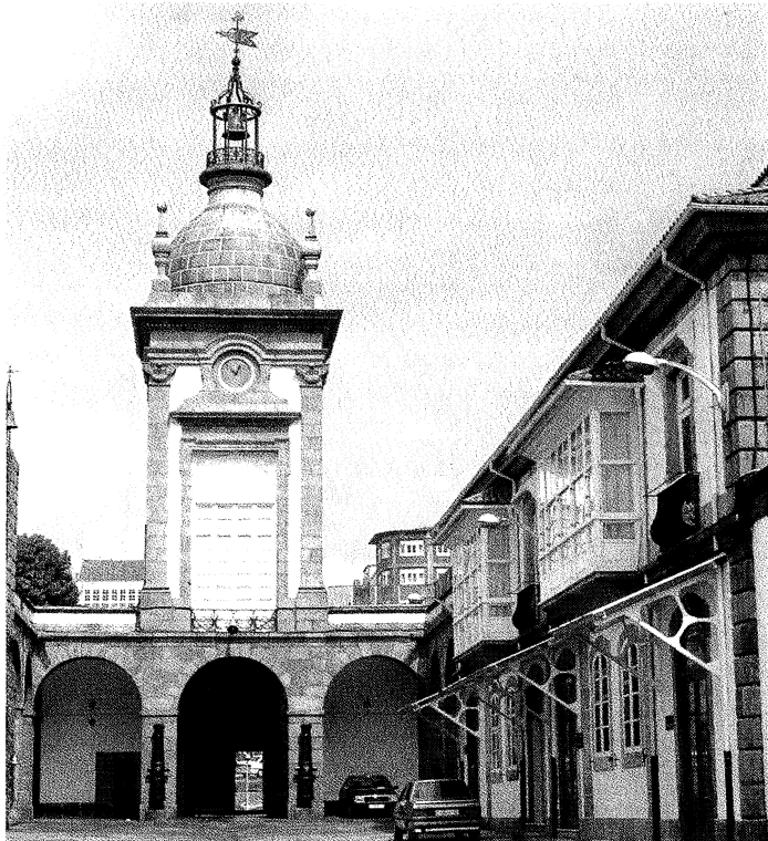
fig.2. Portada y Cuerpo de Guardia del Arsenal del Dique (vista interior), obra de Julián Sánchez Bort
