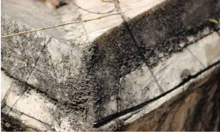
17. შენობის ატმოსფერული დაბინძურების შედეგად გამოწვეული დეკორატიული ელემენტების დაზიანებები
