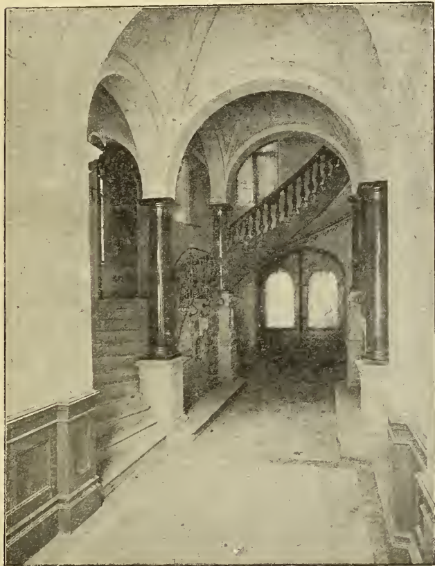
Flurhalle und Stiegenhaus im Erdgeschoss.
