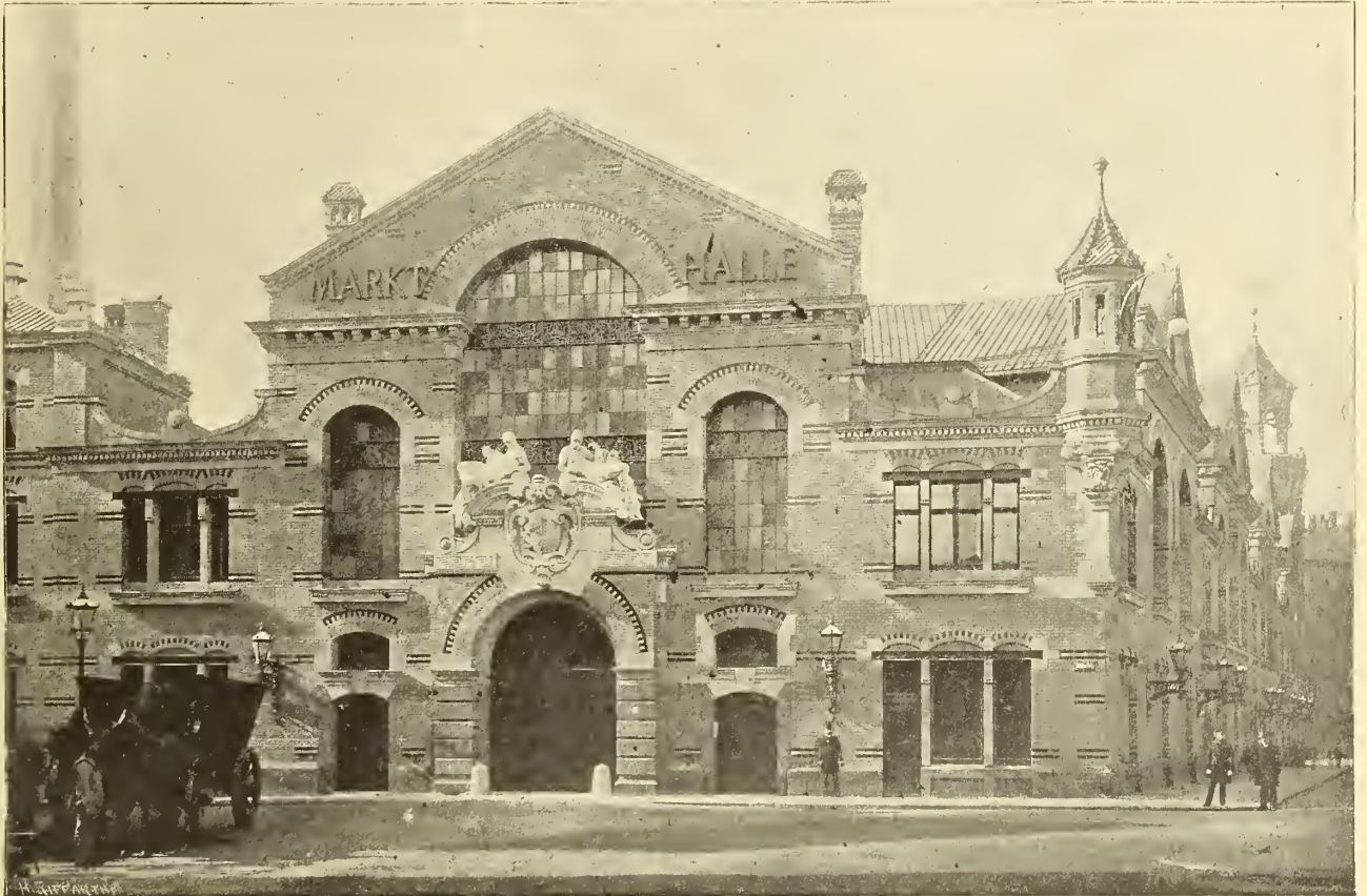
Fassade am Rossplatz.
