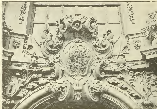
Schlussstein-Bekrönung über der mittleren Bogenöffnung des Erdgeschosses.
