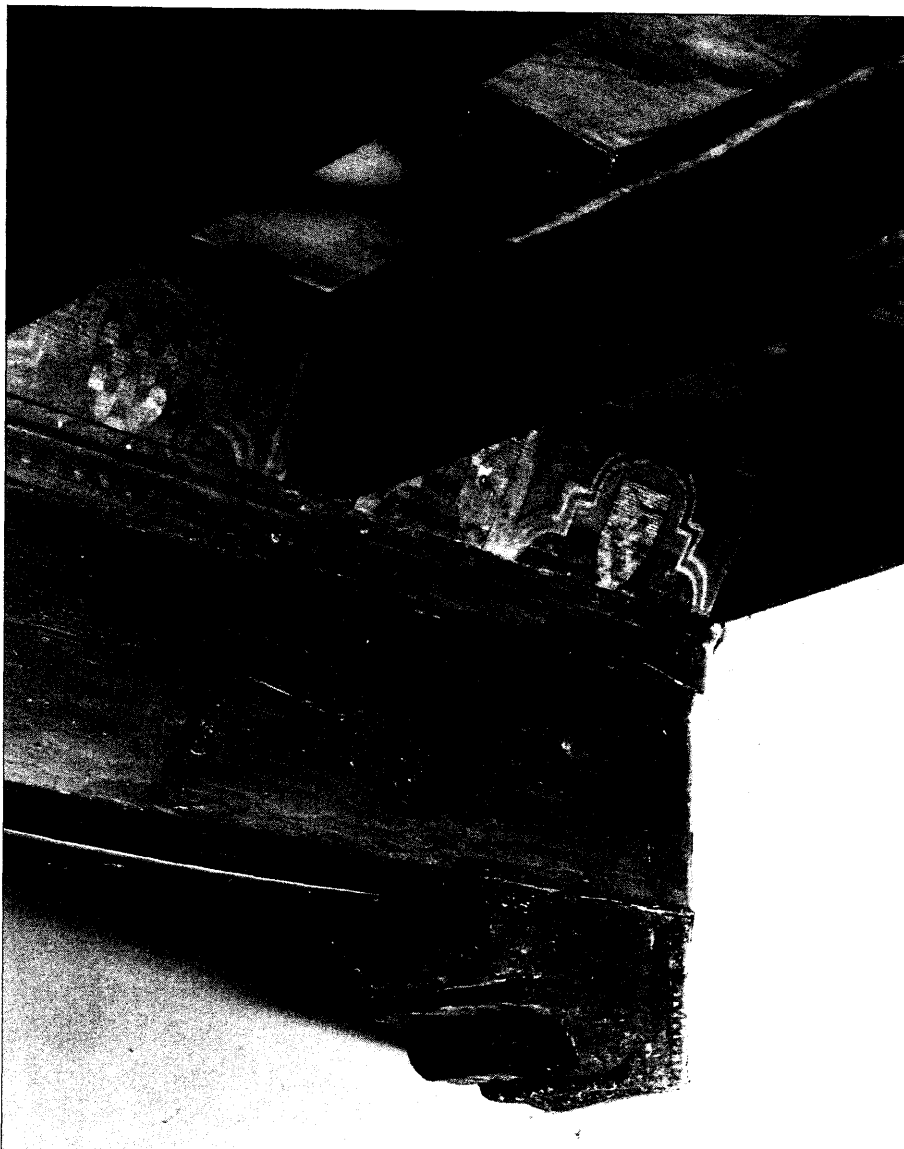
Figura 6. Primo piano della casa: particolare della testata di una delle travi e due tavolette lignee con lo stemma Alberghini.
