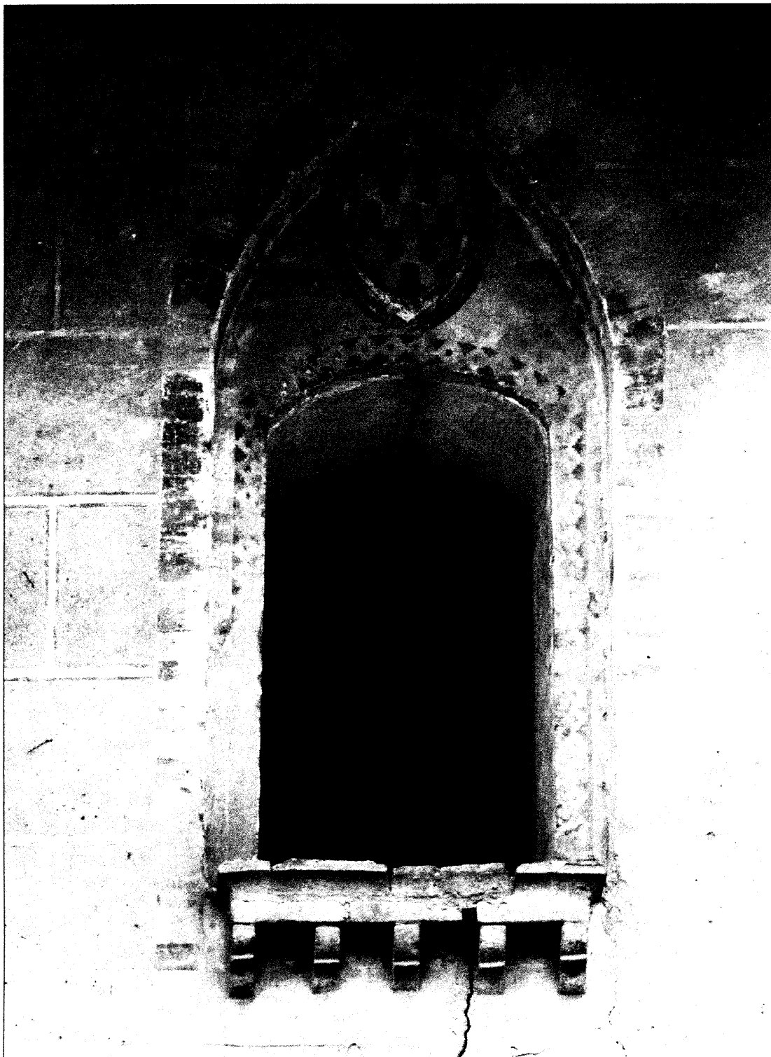
Figura 5. Finestra archiacuta e a rincasso del secondo piano. Osservare in alto lo stemma degli Alberghini.
