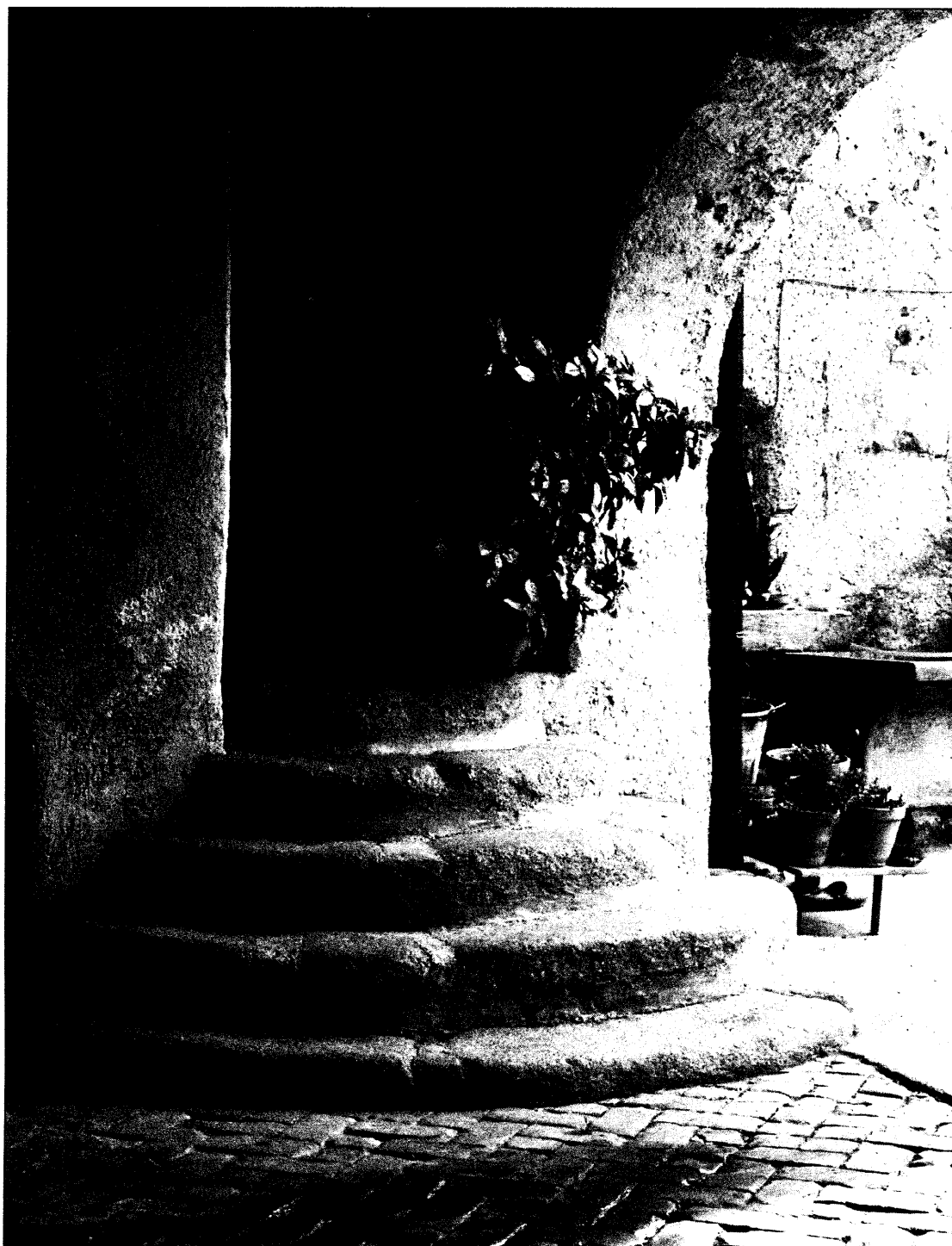
Figura 7. La “scala granda” di granito, all’estremità del portico di pianoterra.
