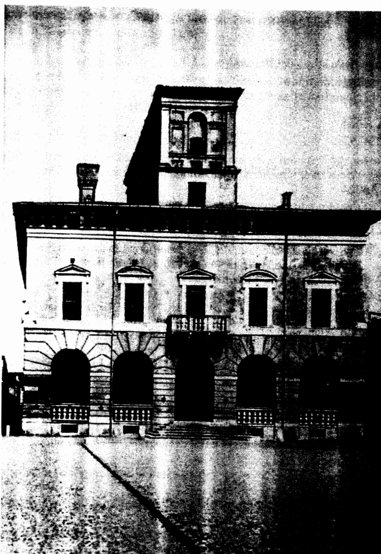
Figura 9. Sabbioneta. Prospetto del Palazzo Ducale.
