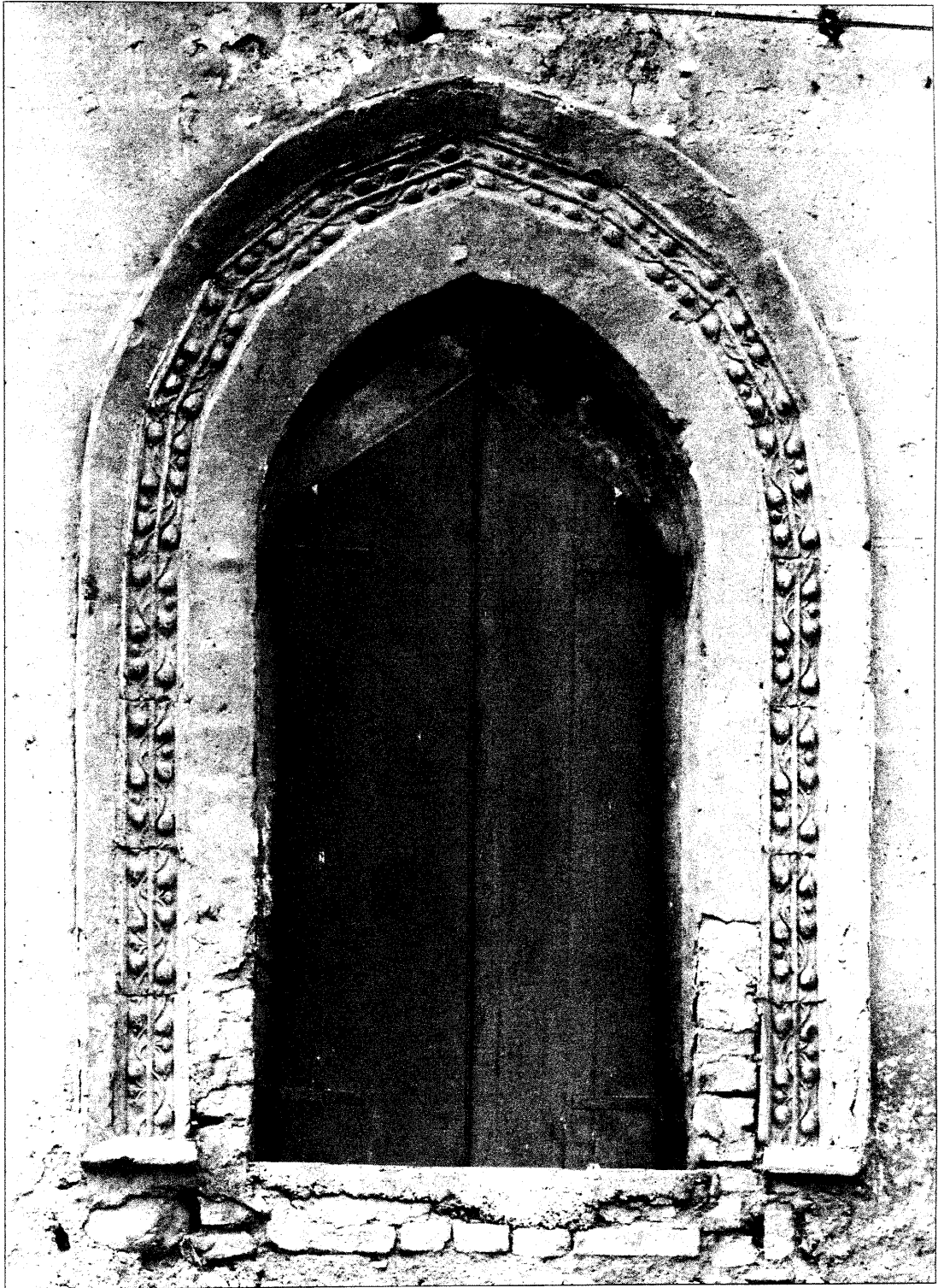
Figura 3. Finestra ad arco ogivale del primo piano, con la stessa corniciatura di cotto della precedente.
