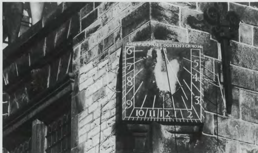
17. De zonnewijzer op het stadhuis heeft drie vlakken. De stijlen links en rechts van het hier zichtbare vlak horen bij de zijvlakken. Foto H.J. van Nieuwenhoven, 1983.
