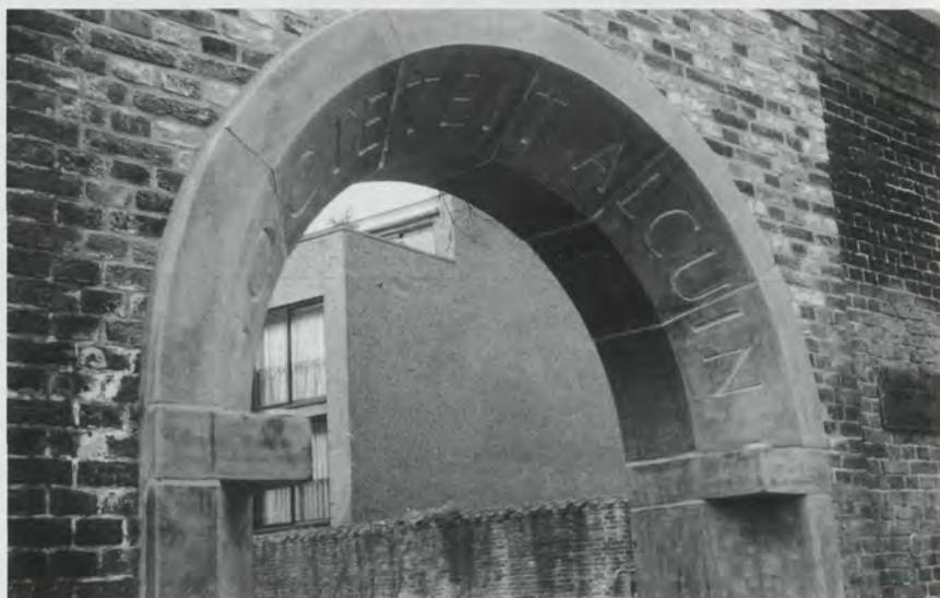
Oude Delft 55/57. De afscheidigsmuur aan de straat kreeg een nieuw ingangspoortje.
