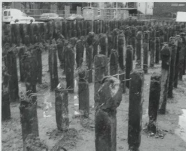
7. Het opgravings- terrein Waterloop- kundig Laborato- rium (het oude Doe- lenterrein), zwaar verstoord door fun- deringspalen
