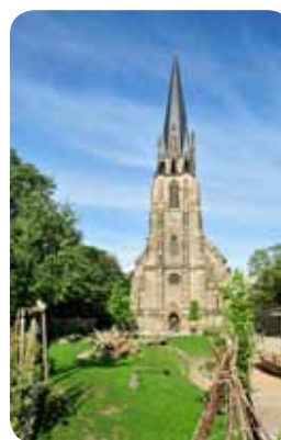
Wird der Seitenturm saniert, dann kann man wieder die Aussichtsplattform der Marienkirche besteigen. Foto: Püllicher
