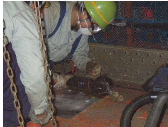
写真-15 摩擦面処理現場施工状況
