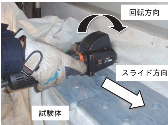
写真-14 ブリストルブラスターによる摩擦面処理状況
