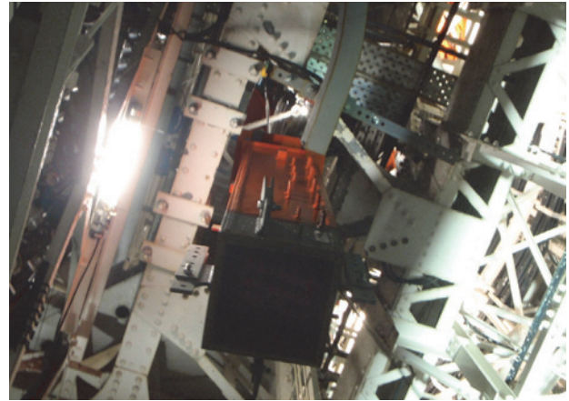
写真-6 B号デリック揚重開口 （新設ST支柱揚重時）
