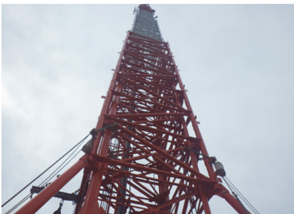
写真-10 SG塔補強フレーム
