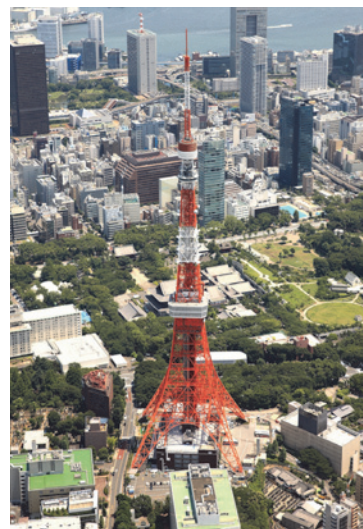
写真-1 東京タワー全景
