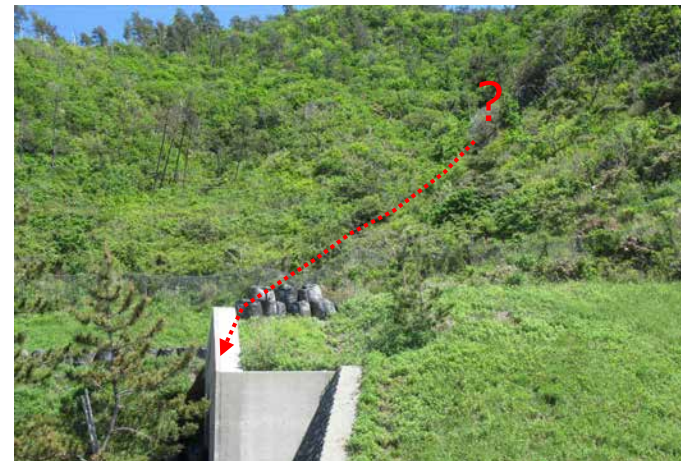
落石経路となった谷地形（発生源位置は本調査では、未確認。余震継続中で斜面内に立ち入りできず）
