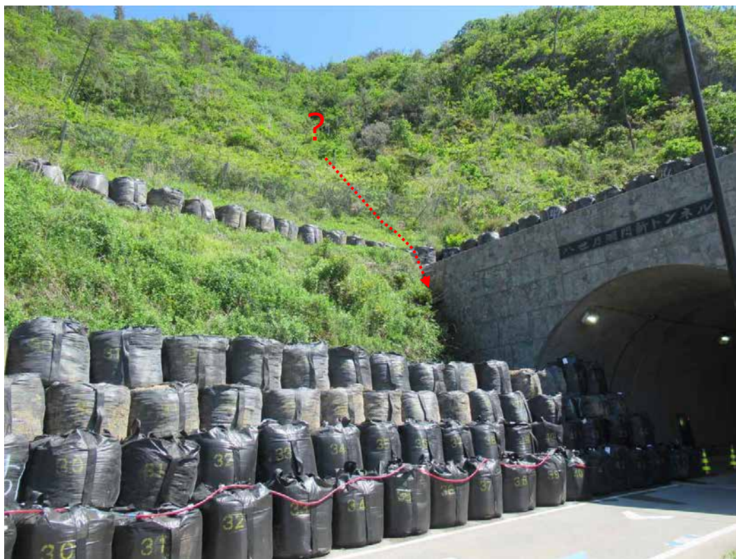
大型土嚢の4段積み 片側交互通行により通行を確保
