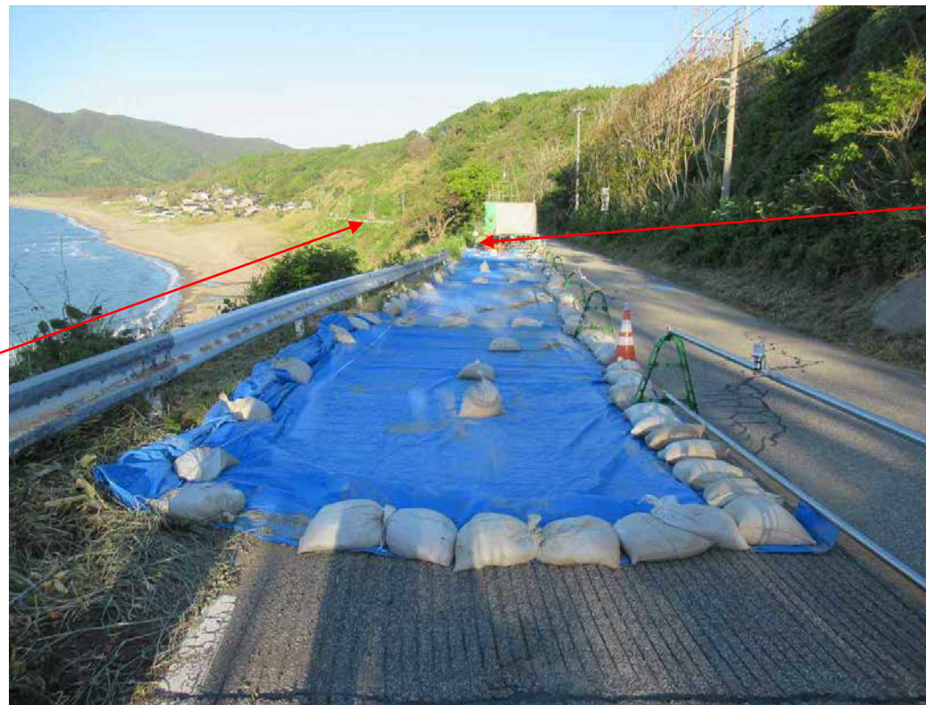
斜面肩部が不安定化し、ガードレールが変形
