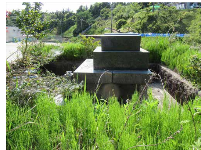
グラウンド横では墓石の倒壊が認められる
