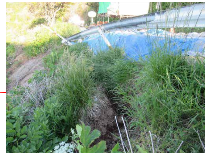
斜面肩部が不安定化し、ガードレールが変形
