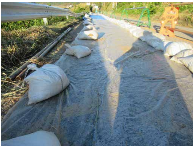
珠洲側でも路肩のクラックが発生している
