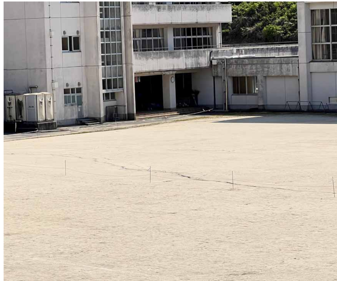
グラウンドに生じた地割れ（開口クラック）。 校舎に被害はない模様
