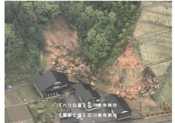
がけ崩れの状況 (珠洲市正院町岡田) ※防災ヘリ「あおぞら号」による撮影
