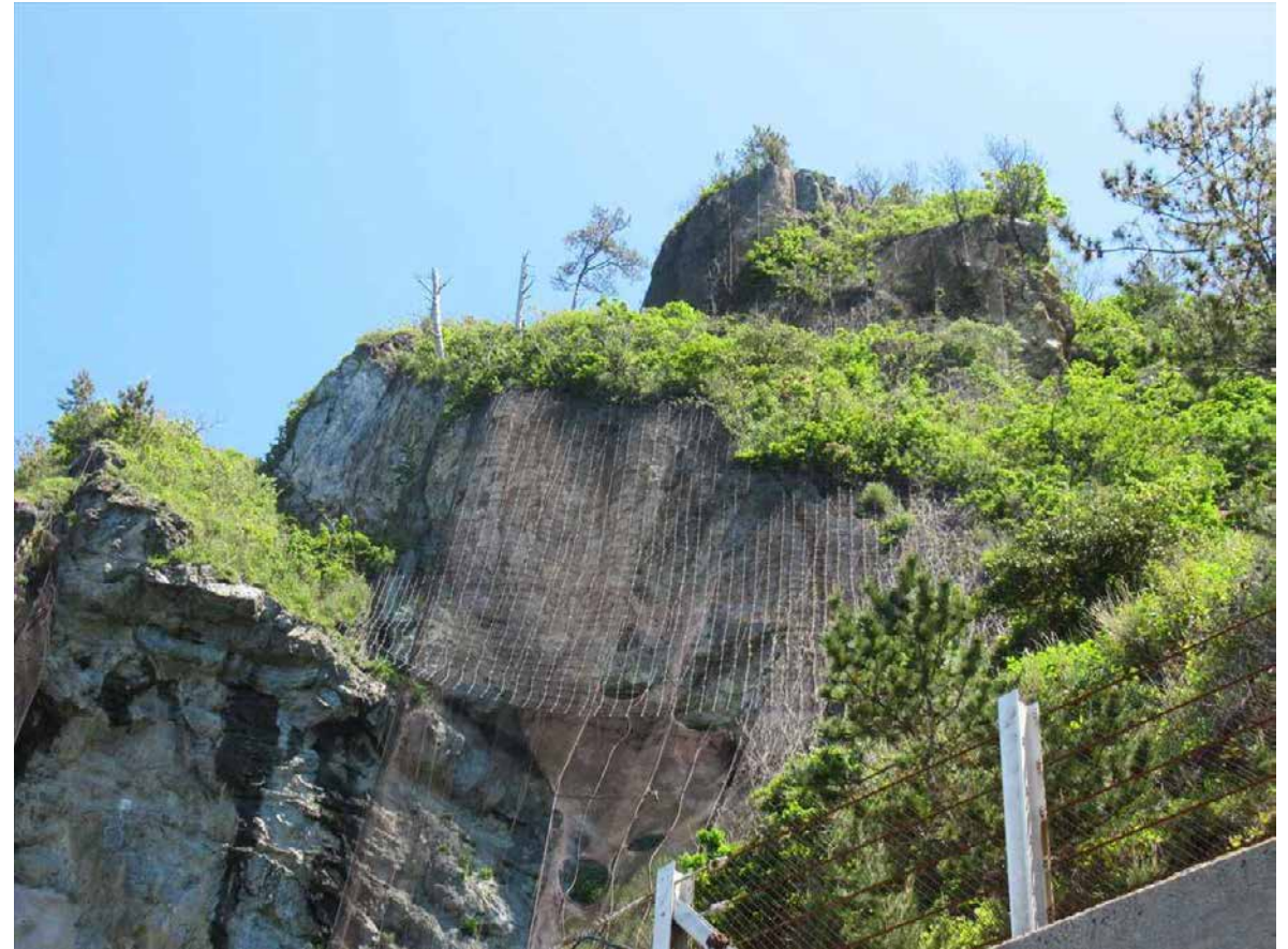
2007年崩落箇所は、応急対策のためのロープネット工 (2007年) が設置されているが、今回の地震による破損等は見られない
