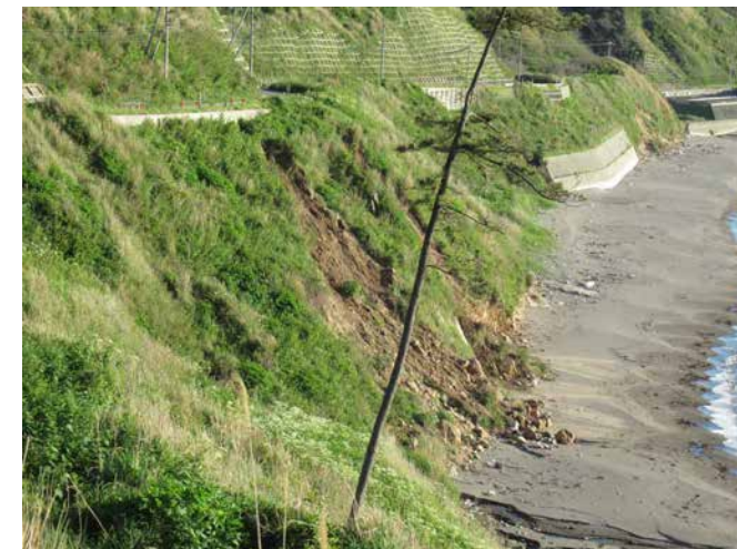
輪島側の道路下斜面の崩壊（路面に異常なし）
