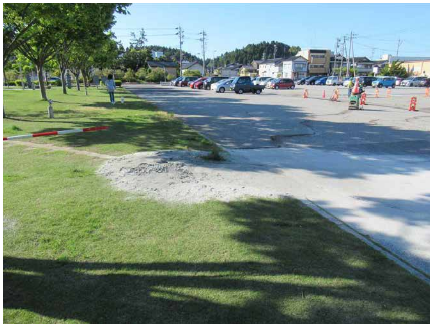
ラポルトすず東側芝生面に生じた噴砂
