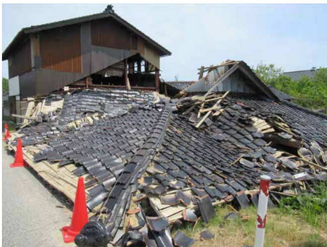
建物倒壊（蛸島） 平屋部分が完全につぶれる。左側の建物に、 つながっていた屋根部分の形が残る
