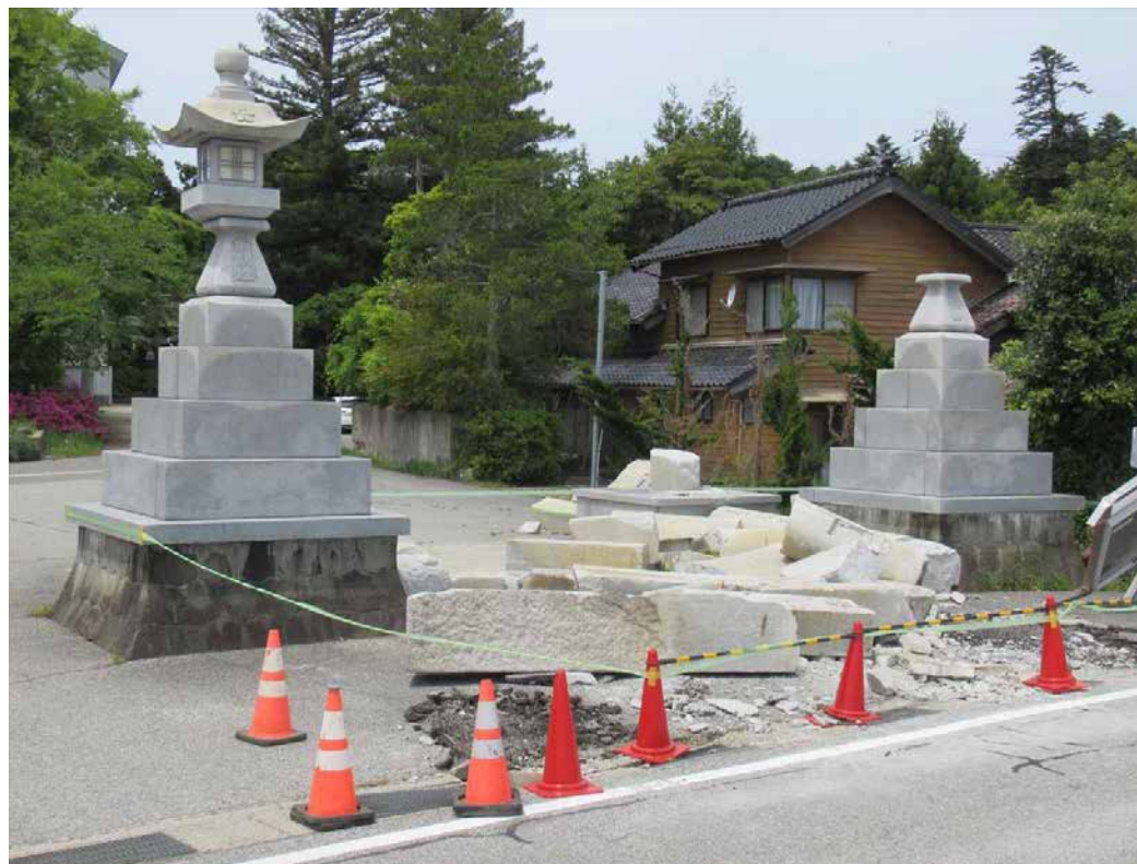
鳥居が海側（東側）に倒壊し大きく破損。右側灯籠上部も落下
