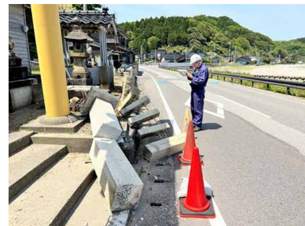
現地調査状況：5/11~5/12
