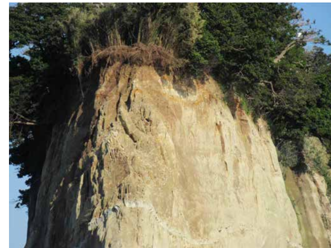
肩部の崩壊状況
