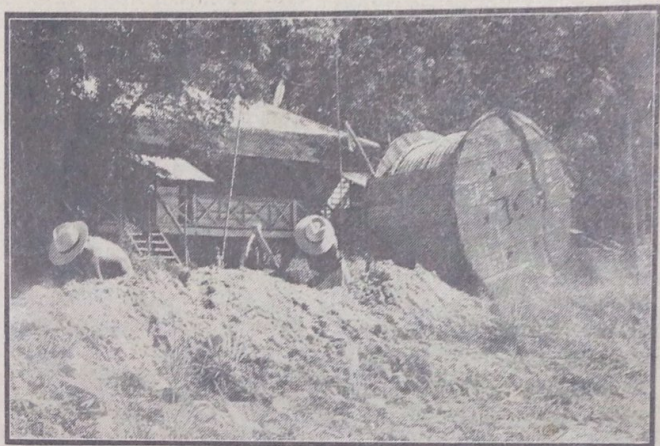
Di-atas, beberapa buah transformer telah di-dirikan di-tepi2 jalan yang menghubungkan pusat electric Bandar Brunei dengan kampong2. Transformer2 itu ia-lah untuk menguatkan tenaga electric. Gambar di-bawah, ini menunjukkan pekerja2 Pejabat Electric Brunei menggali parit supaya cable atau kawat electric di-bawah tanah itu dapat di-tanamkan kelak.
