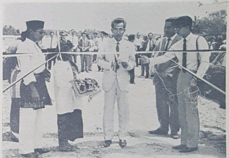
Yang Amat Berhormat, Pemangku Menteri Besar, Pengiran Dato Seri Paduka Haji Md. Yusof sedang melaksanakan pembukaan jalan kecil di-kampung Mulaut pada hari Sabtu lepas.
