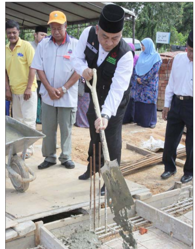
PEMANGKU Setiausaha Majlis Ugama Islam Brunei (MUIB), Awang Haji Abd. Aziz bin Haji Akop ketika menuang simen ke atas tapak rumah baru bagi Awang Haji Narudin bin Haji Pungut.
