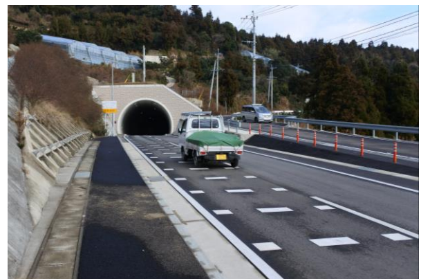
平成29年2月に供用開始した茂木工区
