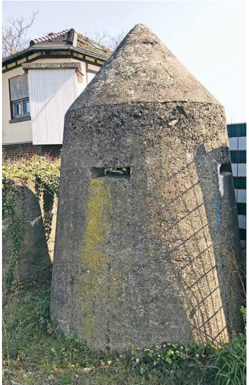
„Splitterschutzzelle“ oder Einmann-Luftschutzbunker neben dem Bahnwärterhaus (li.) in Grullbad, Hochstraße (Foto: G. Möllers), vgl. auch S. 35, 49, 50
