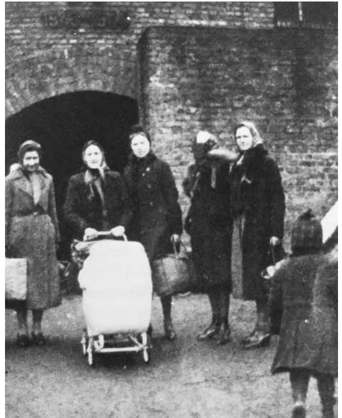
Stollenbunker Halde Wanner Straße 1943 (Hochlarmarker Lesebuch, S. 191)
