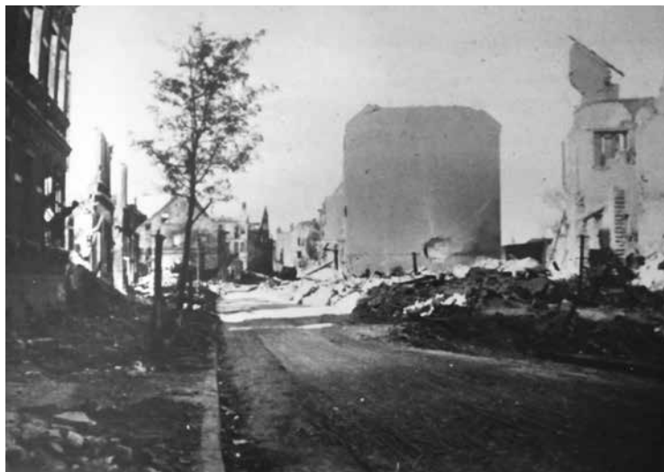
Zerstörungen am Oerweg, März/April 1945 oder wenig später, (Stadt- und Vestisches Archiv Recklinghausen, Bestand Verkehrs- und Verschönerungsverein Nord e.V., Nr. 41).
