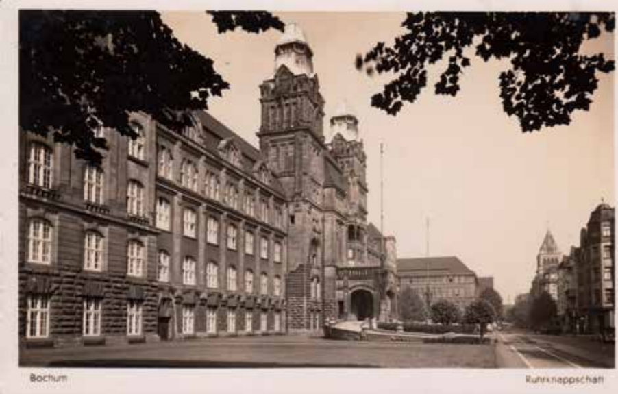
Knappschaftsgebäude in den 1930er-Jahren.
