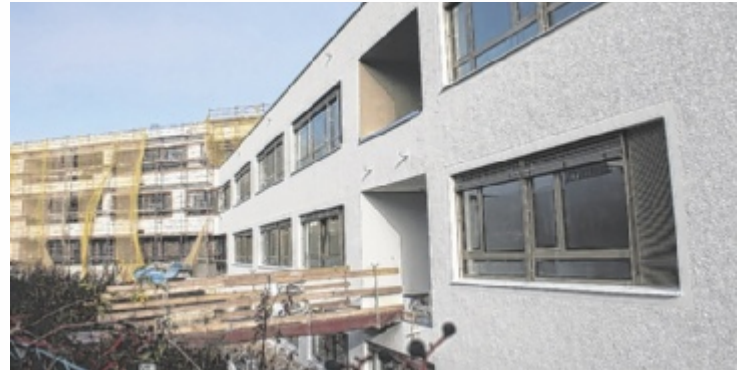
Derzeit wird am Schulcampus am Vollwärmeschutz gearbeitet.
