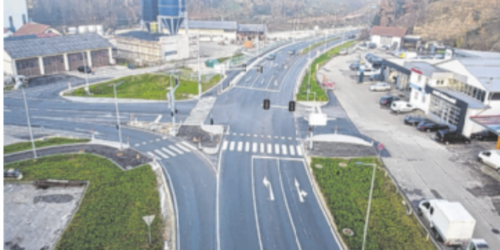
Eindrücke der Baumaßnahmen rund um die neue gestaltete Bum-Kreuzung
