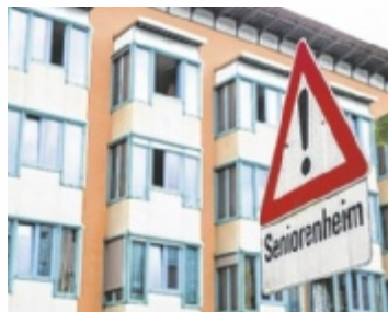
Pflegekräfte in Seniorenheimen sollen entlastet werden. Foto: Wodicka
