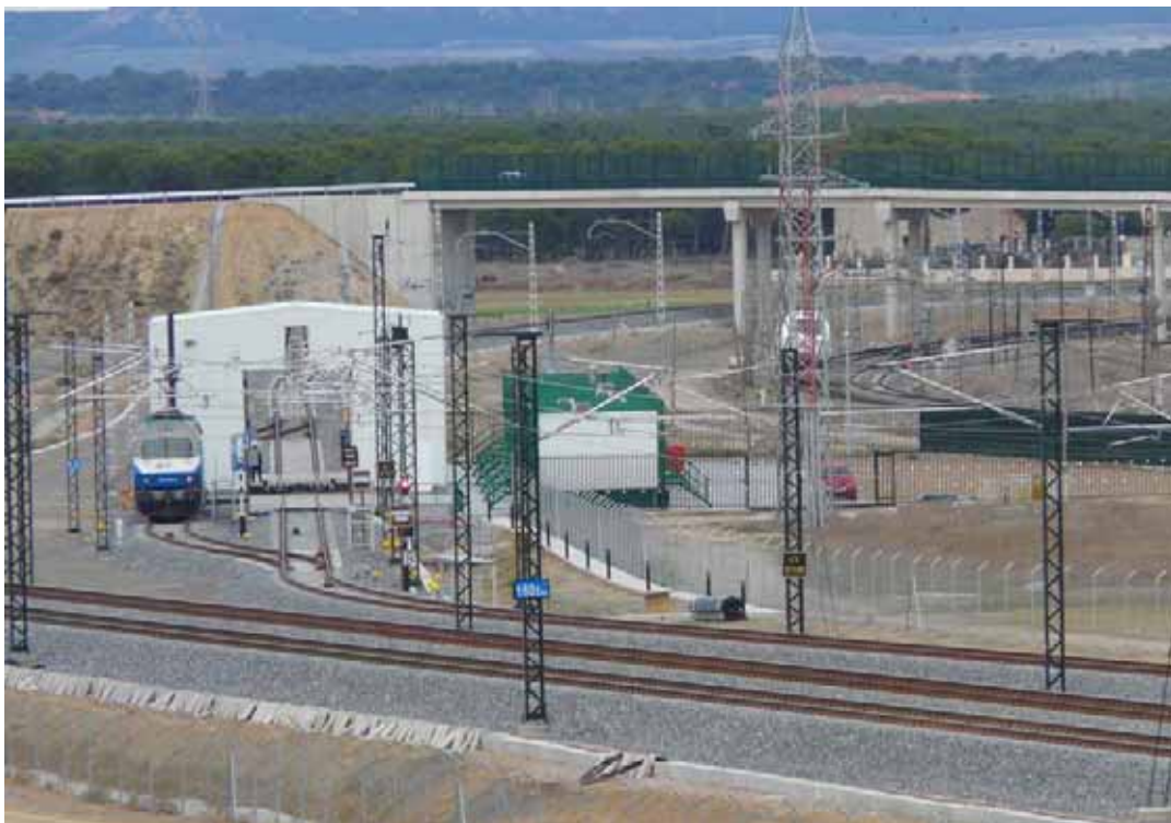
General view of changer at Valdestillas, Valladolid. (Photo: Sara Izquierdo)
