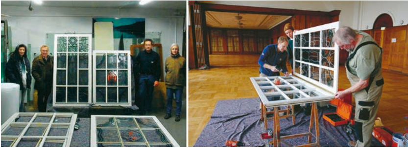
Abb. 114: Die beiden Glasmalerinnen und die Tischler beim Einrahmen und Einbauen der Fenster vor Ort.
